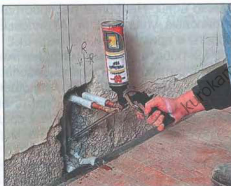
Рис. 183. Работа с монтажной пеной
