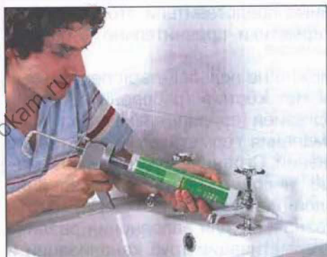
Рис. 182. Заделка стыков силиконовыми герметиками
