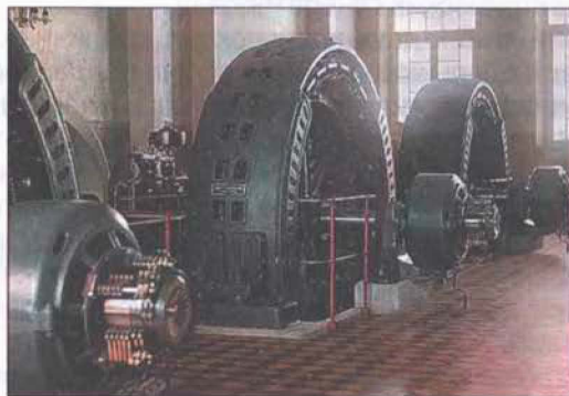
Рис. 157. Генераторы Гиндукушской ГЭС на реке Мургаб
